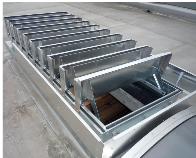
Fig. 40 – Appareil à lames mcr LAM monté en toiture
