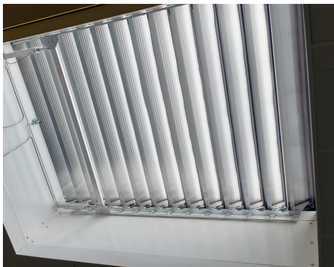
Fig. 39 – Appareil à lames mcr LAM monté en toiture – vue intérieure
