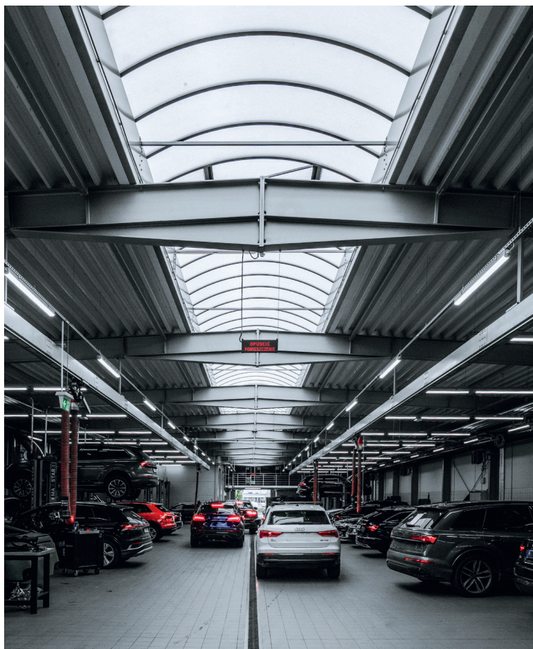
Fig. 2 – Lanterneau continu mcr PROLIGHT vu de l'intérieur
